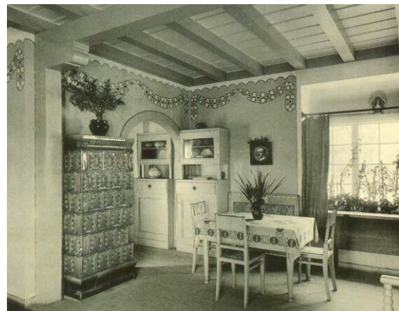
Olbrich: Arbeiterhaus, Wohnzimmer Laborista domo, loĝoĉambro
